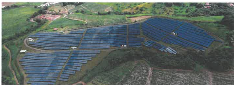
Exemple - Parc solaire en Martinique qui respecte la topographie en cherchant à suivre les courbes de niveau
